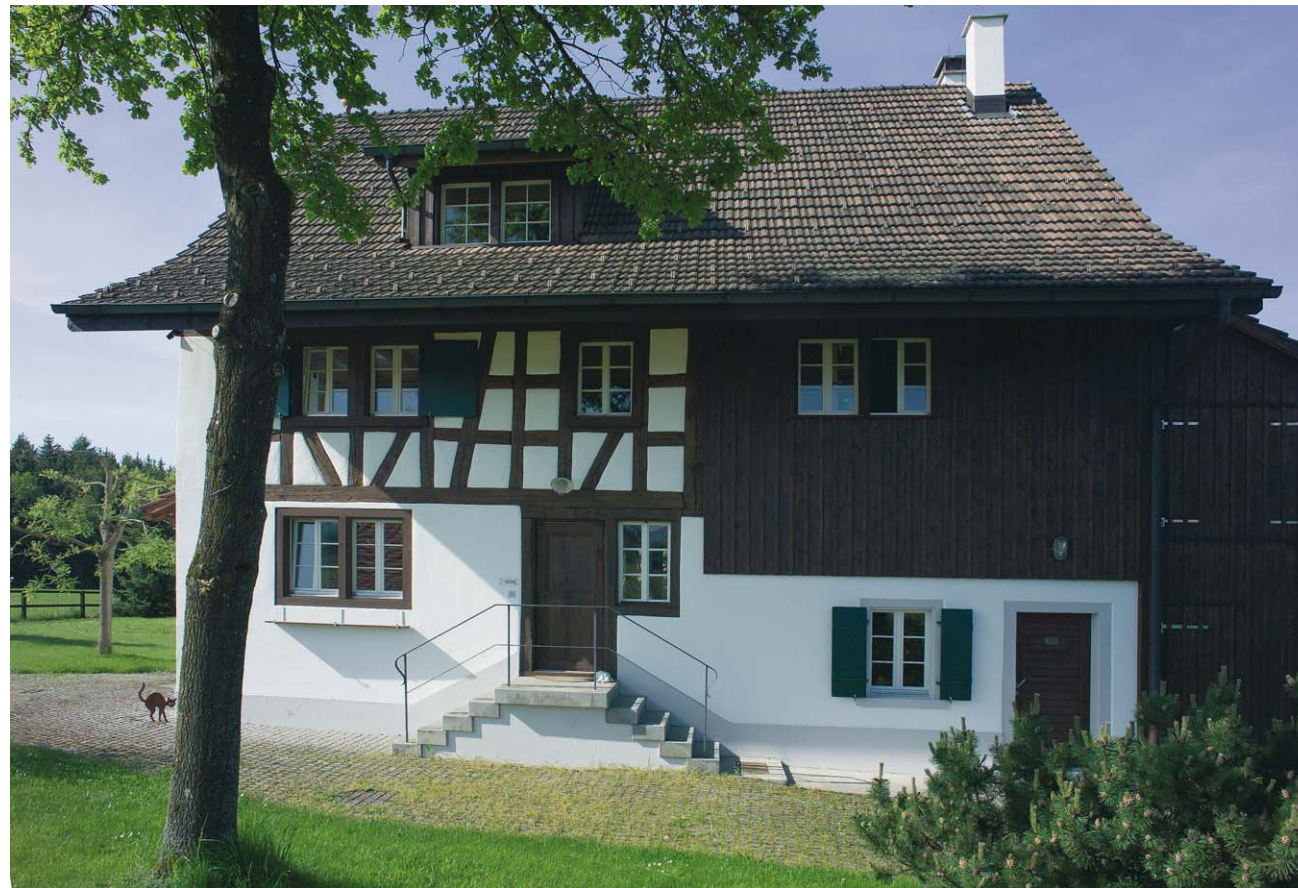
Das äussere Erscheinungsbild des Riegelbaus mit Baujahr 1784 wurde erhalten und die Fassade entsprechend renoviert. Liebevoll gestaltet zeigt sich auch der passend zum Haus angelegte Garten.
